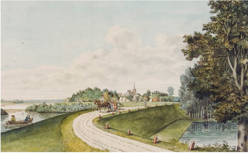
Illustratie 1 De Waaldijk met op de achtergrond het dorp Ochten in de Neder-Betuwe. De (genummerde) paaltjes wijzen erop dat onderhoudsplichtigen elk een eigen deel van de dijk onderhielden. Deze dijk was dus niet gemeengemaakt.
